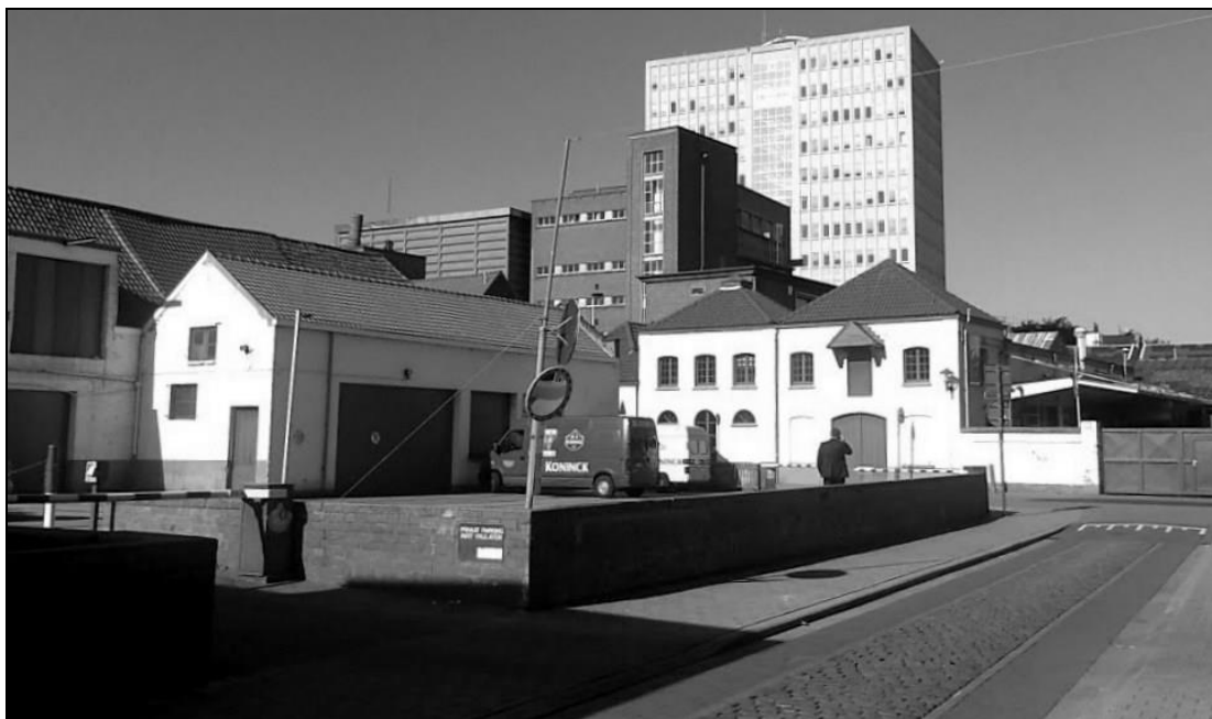
De achterzijde van de gebouwen van brouwerij De Koninck.
