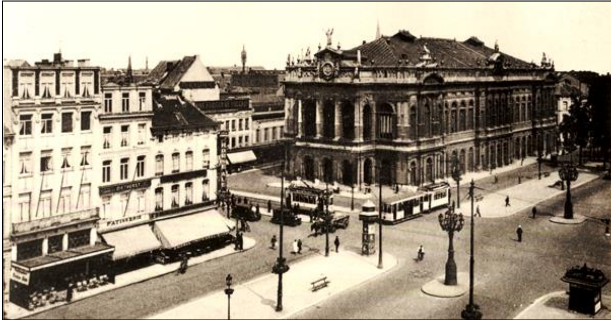
De Nederlandse Schouwburg aan de Kipdorpbrug.
