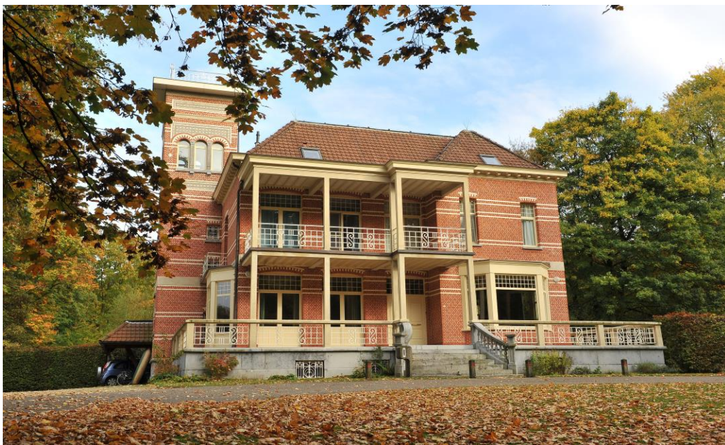
De villa Albert, huidige toestand. De rondom doorlopende veranda werd bij de renovatie gedeeltelijk verwijderd.
